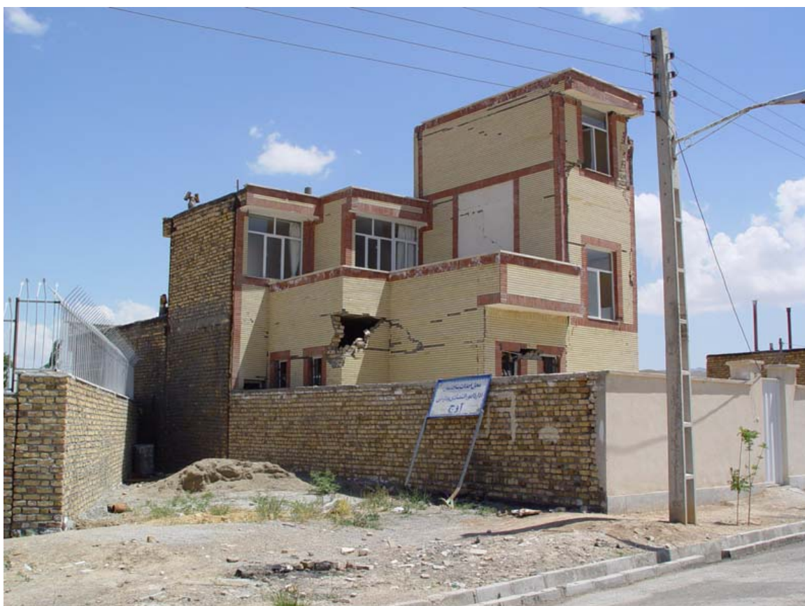
تصویر شماره ۶- نمای عمومی ساختمان امور اقتصادی بخش آوج
