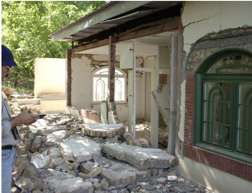
تصویر شماره ۱- فرو ریختن دیوار میانقاب در یک ساختمان ۲ طبقه در بخش آوج
