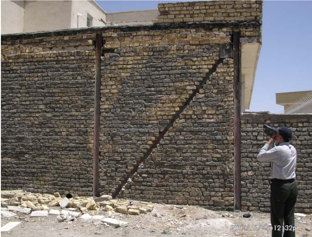
تصویر شماره ۹- تنها مهاربندی قابل رؤیت در ساختمان تصویر شماره ۶
