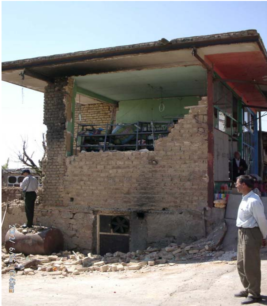
تصویر شماره ۱- فرو ریختن دیوار میانقاب در یک ساختمان ۲ طبقه در بخش آوج
